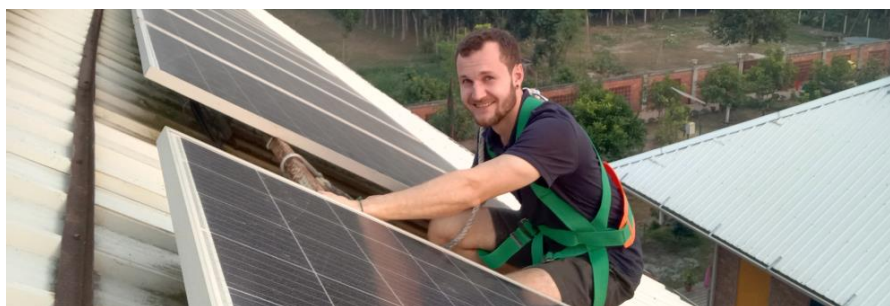
Überprüfen der Solarpanels auf dem Dach der Schule
